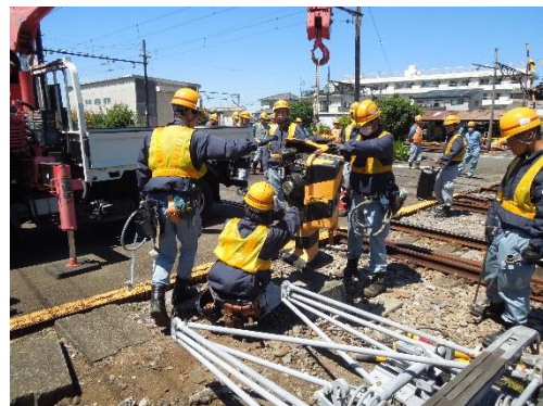
踏切遮断機復旧訓練②
