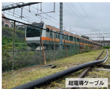
図 4 超電導による電力供給区間を走行する電車（中央本線での大電流供給）
