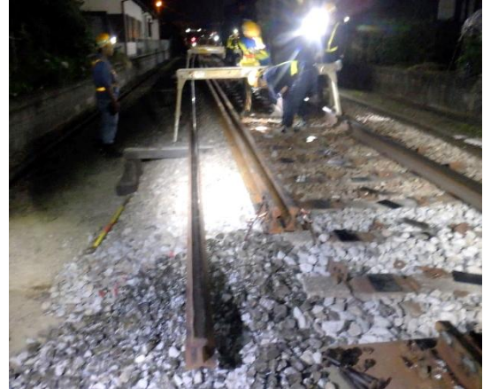
レール交換作業
