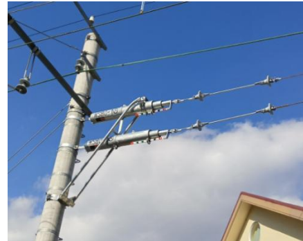
自動調整式 架線張力調整装置
