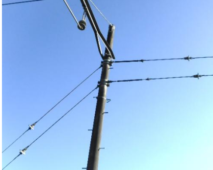
手動調整式 架線張力調整装置
