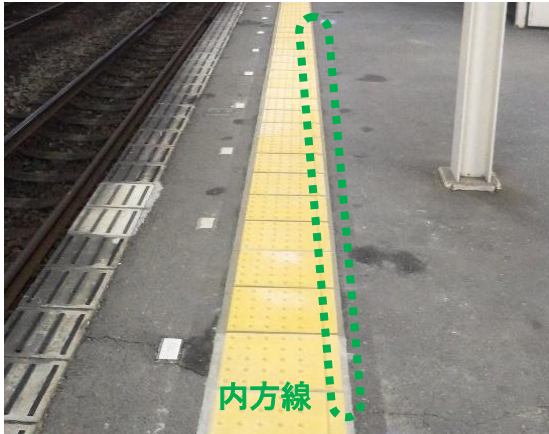
大場駅 内方線付点状ブロック
